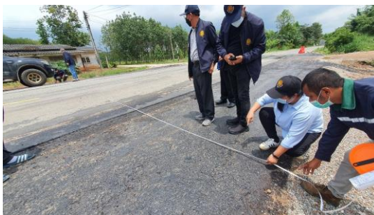
ภาพการลงพื้นที่ตรวจติดตามก่อสร้าง กิจกรรมย่อย พัฒนาปรับปรุงขยายผิวจราจรลาดยาง สาย รย. ๕๐๐๒ แยก ทช. รย. ๔๐๐๕ - บ้านคลองยาง อ.เขาชะเมา จ.ระยอง เชื่อมเขต อ.บ่อทอง จ.ชลบุรี
