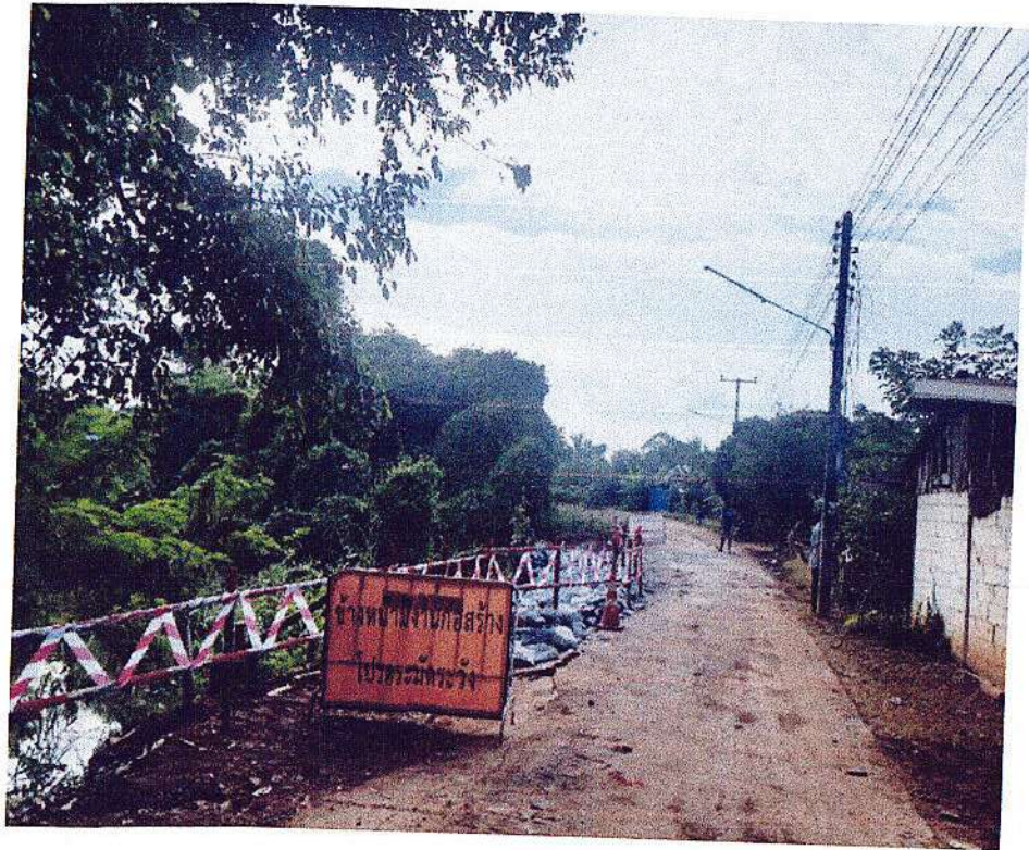
รูปภาพการติดตั้งป้ายแจ้งเตือน
