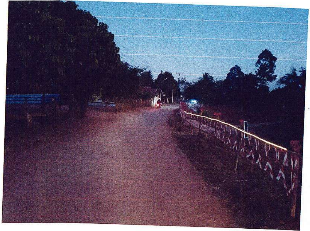
รูปภาพการติดตั้งไฟฟาส่องสว่าง
