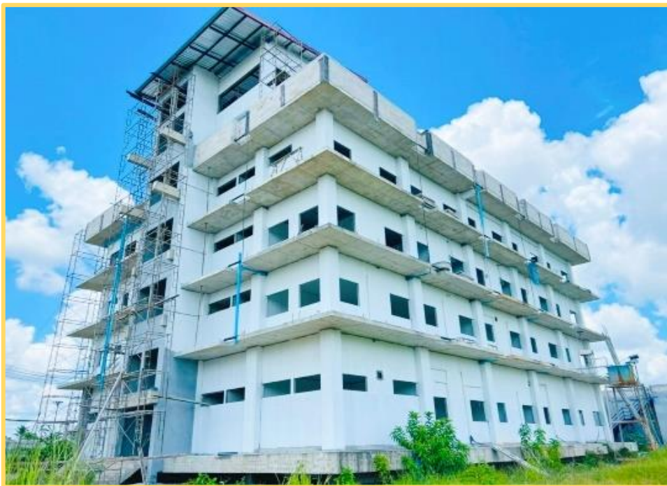
ก.ธ.จ. สุราษฎร์ธานี ลงพื้นที่ตรวจสอบโครงการก่อสร้างอาคารที่ทำการศูนย์พิสูจน์หลักฐาน ๘ (สุราษฎร์ธานี) ตำบลท่าข้าม อำเภอพนม จังหวัดสุราษฎร์ธานี
