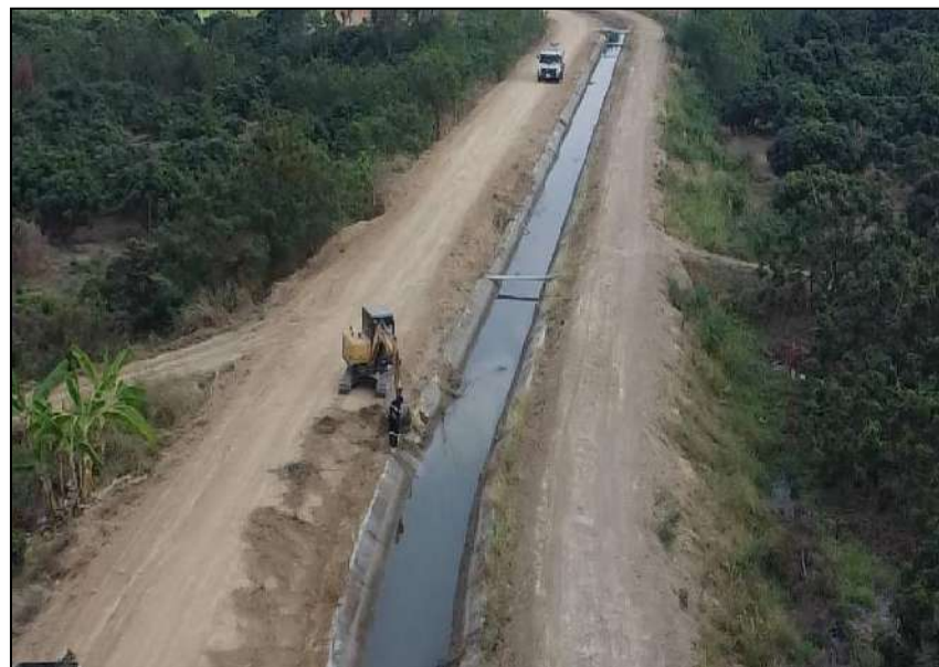
งานแต่งลาดคลองส่งน้ำสายใหญ่ฝั่งซ้าย กม.25+700 - 29+000
