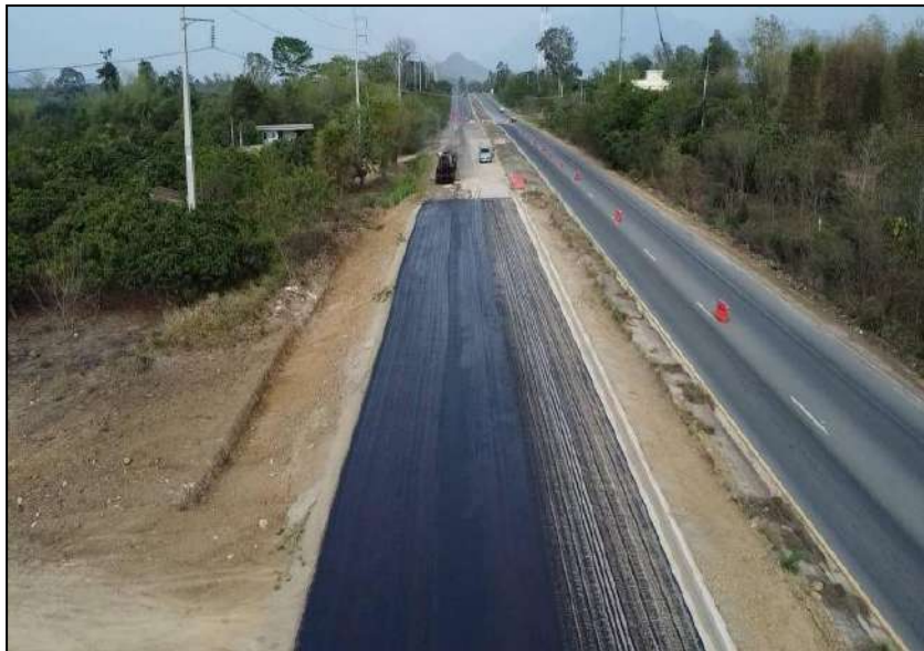
งานลาดยางรองพื้นทาง (Prima Coat) กม.10+050
