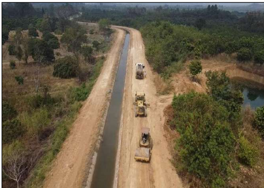
งานปรับปรุงทางลำเรียงคลองส่งน้ำสายใหญ่ฝั่งซ้าย กม.25+700 - 29+000
