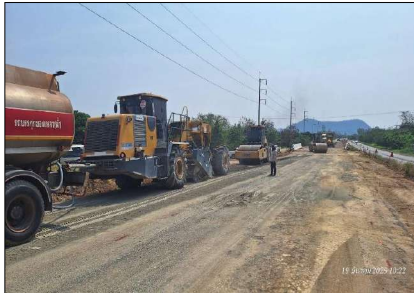
งานพื้นทางหินคลุกผสมกับปูนซีเมนต์ ชั้นพื้นทาง กม.10+050
